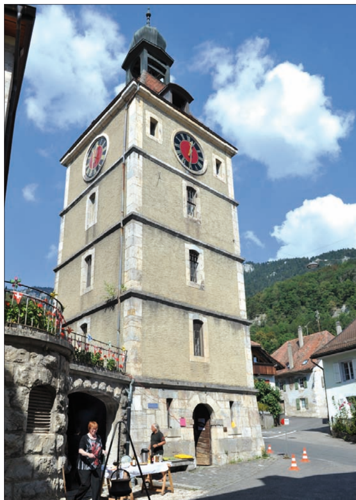
Une fois n'est pas coutume, le public a pu visiter la tour de Baulmes.
