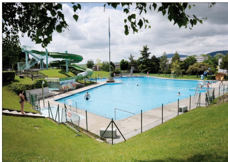
Le plan d'eau et les bâtiments devraient être largement rénovés. Jacquet-a
