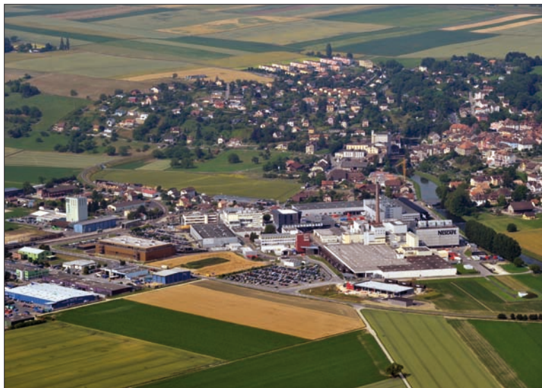
Orbe, l'un des trois villages concernés par la construction du RIPO. Duperrex-a
