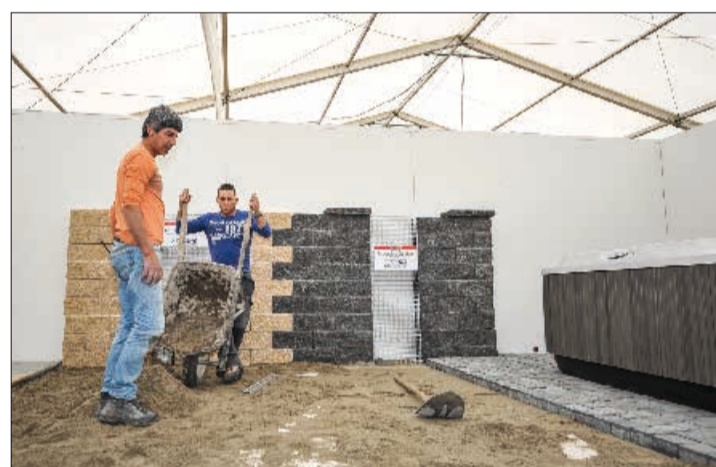
Léno Marques et Joao Cardoso sur le chantier du stand d'Alizé Piscine Service.
